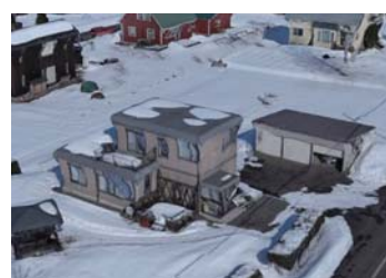
写真13 陸屋根の状況
