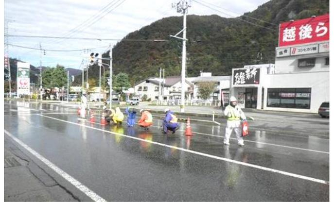
写真1 消雪パイプノズルの点検状況
