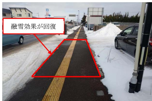
写真8 放熱管の洗浄効果（洗浄後）
