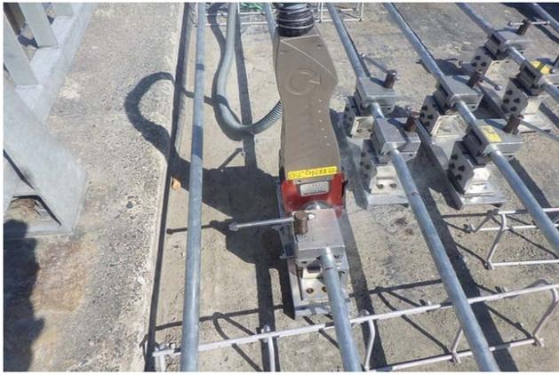
写真1 放熱管の現場溶接 (TIG溶接)
