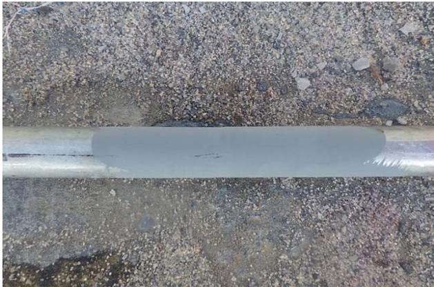
写真2 放熱管の溶接箇所 (亜鉛めっき塗装)
