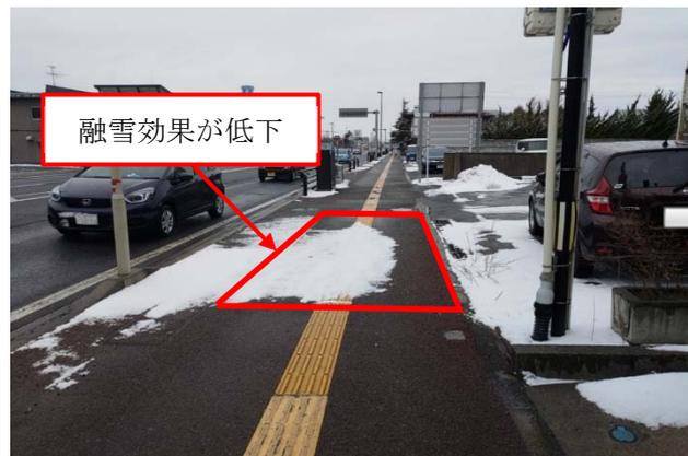
写真7 放熱管の洗浄効果（洗浄前）
