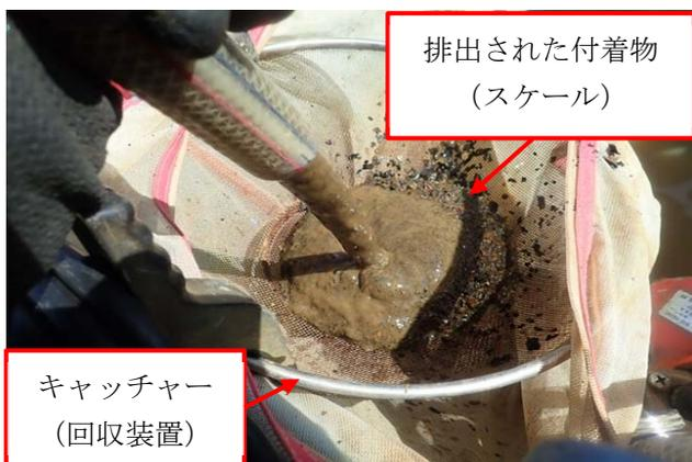
写真5 キャッチャー（回収装置）へのスケール排出
