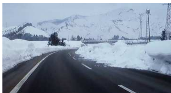
図－6 中分雪堤崩れの状況 6)
