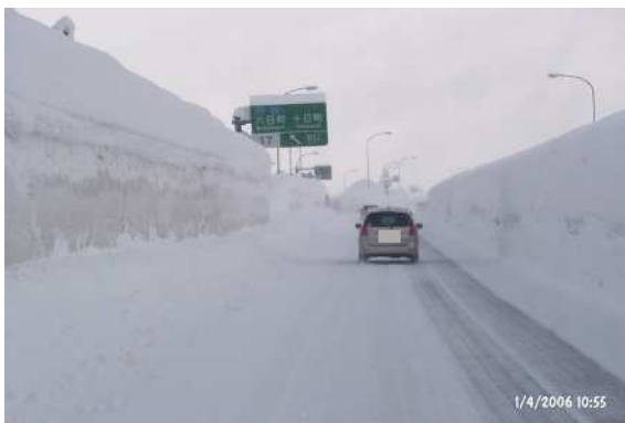
図-1 路側雪堤と中分雪堤 (2006 年 1 月 4 日 10 時 55 分、関越自動車道下り、六日町 IC 付近)
