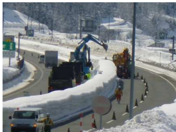
図-4 中央分離帯規制による中分雪堤の運搬排雪
