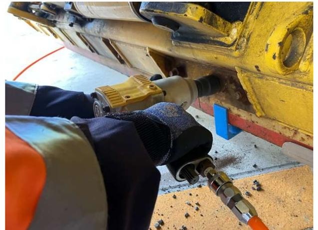
写真10 プロボルトオサエールによる交換作業
