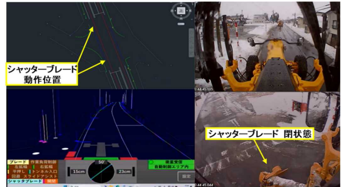
図10 現場適応性試験状況
