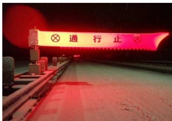
写真 2. エアー遮断機
