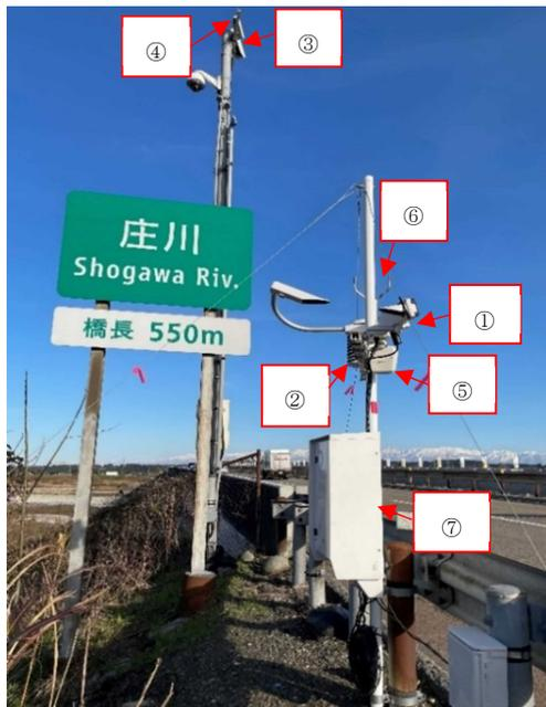
写真1 試行導入した気象観測局
