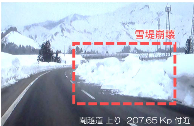
図-1 過去に高速道路上で発生した規模の大きな雪堤崩壊
