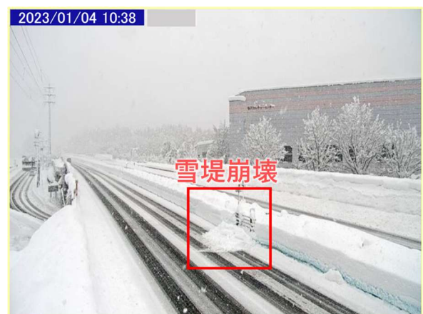
図-2 ウェブカメラ画像より観測できた雪堤崩壊の一例
