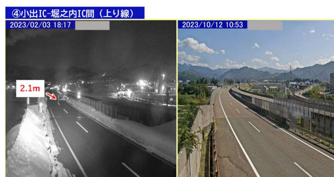
図-7 特に規模の大きな雪堤崩壊④
