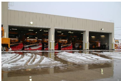
写真1：滑川(なめりかわ)除雪基地
