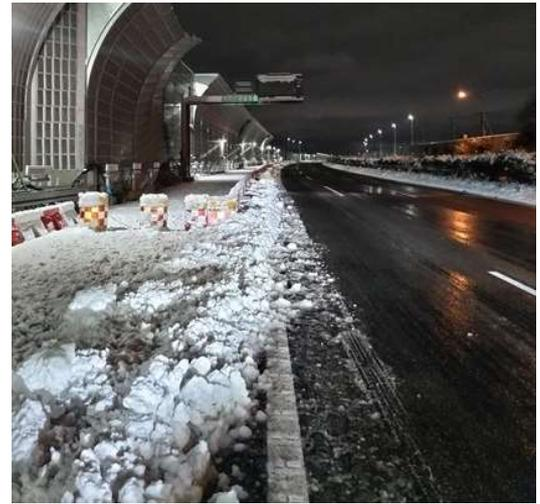
図-8 外側線に残雪している状況
