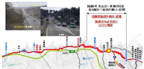
図3 米山台～青海川の急勾配かつ起伏が激しい区間
