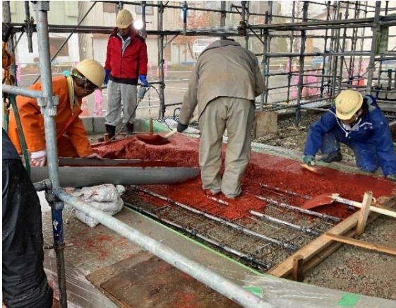
写真5 実験部の放熱管と打設状況
