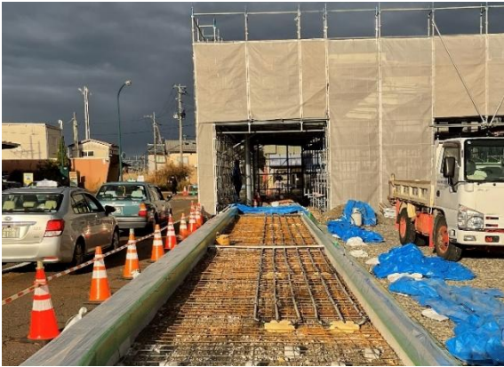
写真2 一般部の放熱管設置状況
