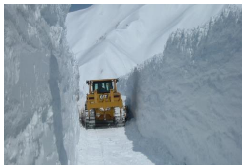
写真4 ②一車線除雪
