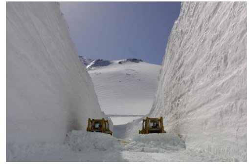
写真7 ブルドーザ2台による雪の壁の切り下げ
