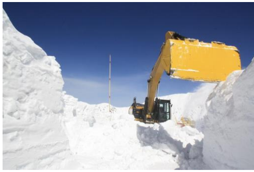
写真5 ③拡幅除雪（バックホウ）
