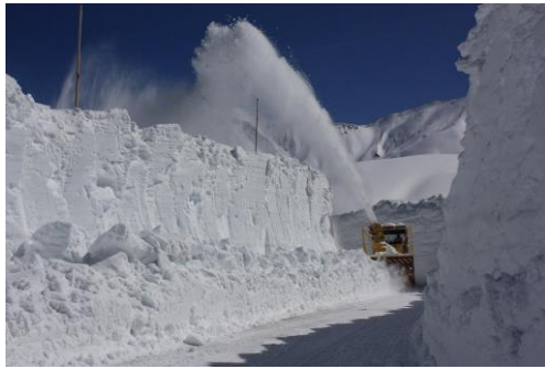
写真6 ③拡幅除雪（ロータリ除雪車）
