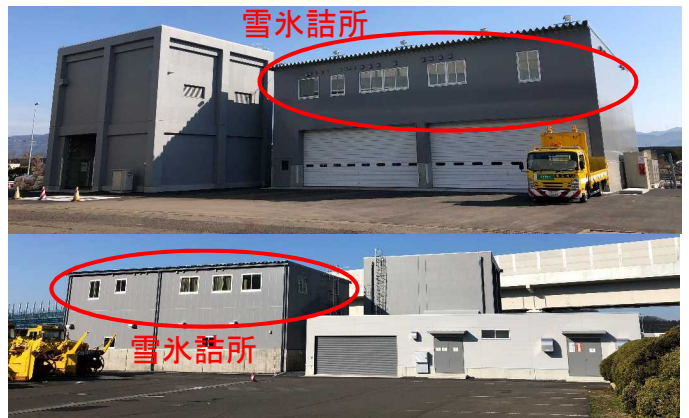
写真4 施工後（新築後）
