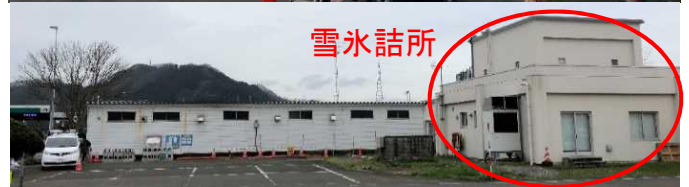
写真3 施工前（解体前）
