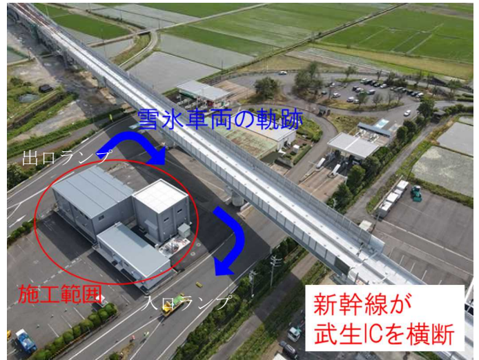
写真1 武生 IC 管理施設新築後の全景
