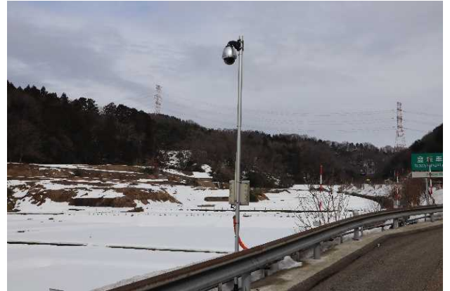
写真-1 クラウドカメラ設置状況
