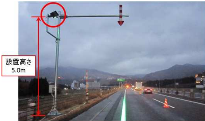
写真2 帯状ガイドライト設置状況
