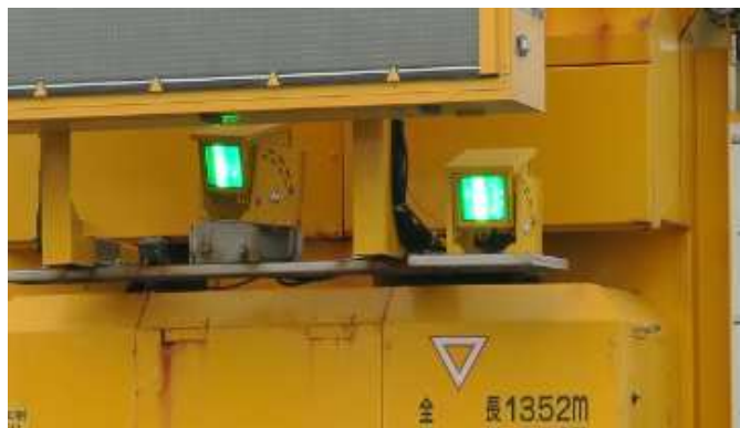
写真４ セーフティライン設置状況（２灯式）
