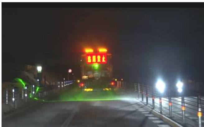
写真7 セーフティライン 対面区間1灯点灯中
