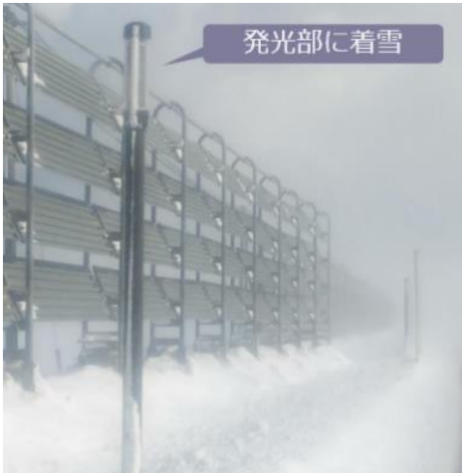
写真4 太陽電池式自発光視線誘導標の着雪状況
