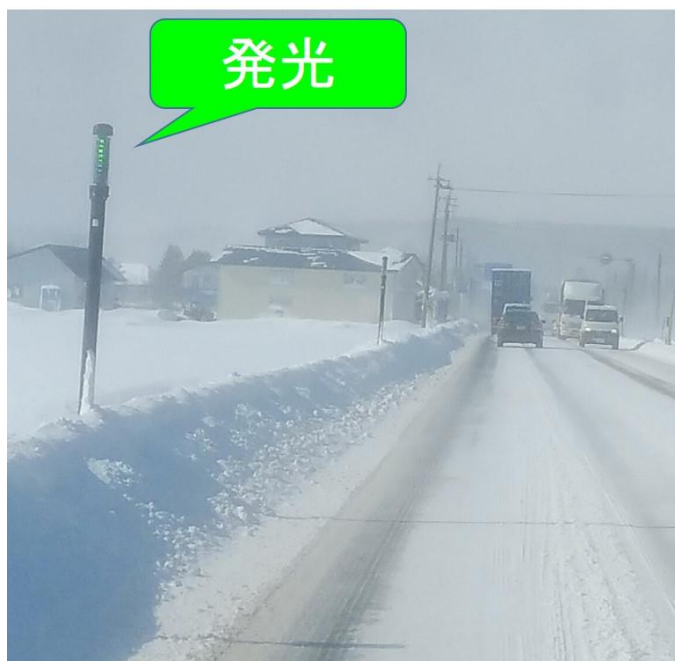
写真3 太陽電池式自発光視線誘導標の発光状況
