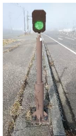
写真1 視線誘導標(商用電源)
