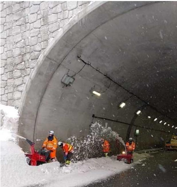
(写真6) 小型ロータリー除雪機でのトンネル坑口除雪
