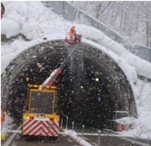
(写真7) 高所作業車でのトンネル上部除雪
