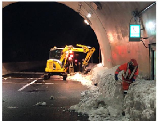
(写真5) 小型バックホウでのトンネル坑口除雪
