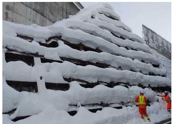
(写真10) 雪崩防止施設の堆雪を除雪
