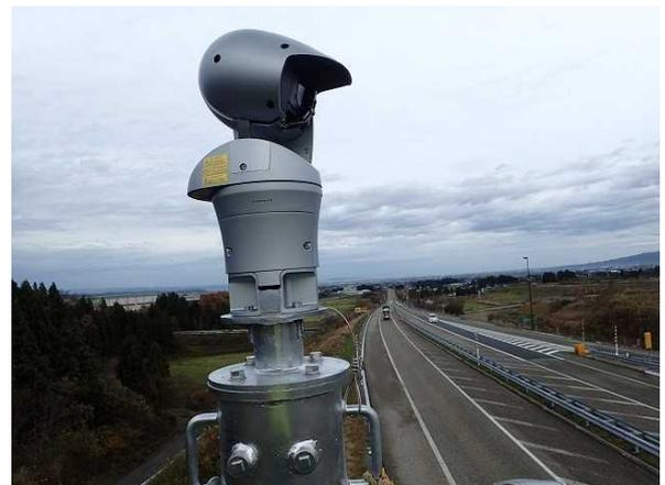
写真-5 CCTVおよびWEBカメラ設置イメージ
