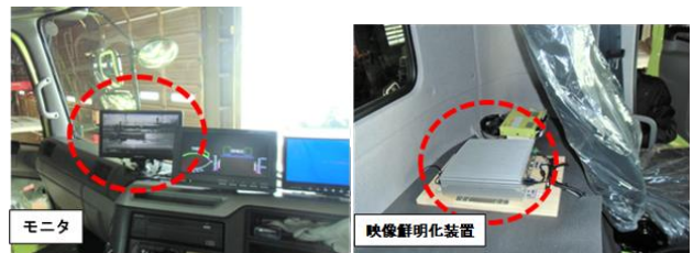
写真-5 映像鮮明化装置取付状況
