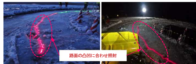
写真 7 凹凸路面のレーザー照射状況
