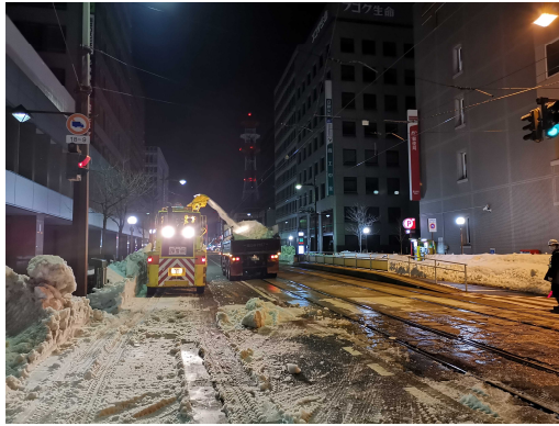
写真4 路面電車通りでの拡幅除雪・排雪状況
