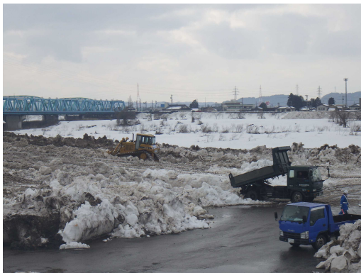
写真5 雪捨て場への排雪状況
