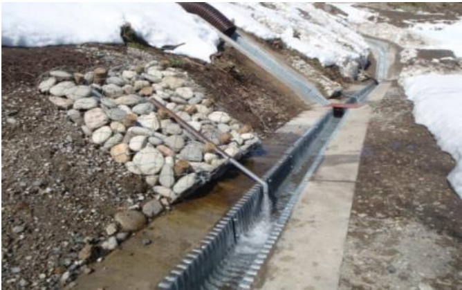
写真 3 ボーリング工からの地下水の排水量
