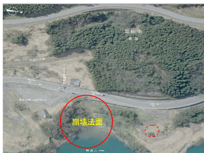
写真4 崩壊前の法面位置と背後地形
