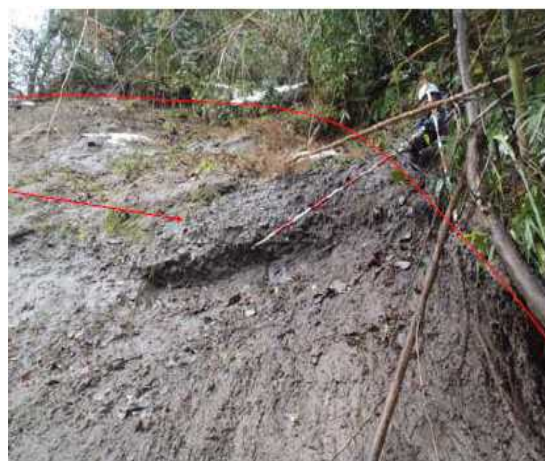
写真2 表層滑落直後に基岩が露呈
