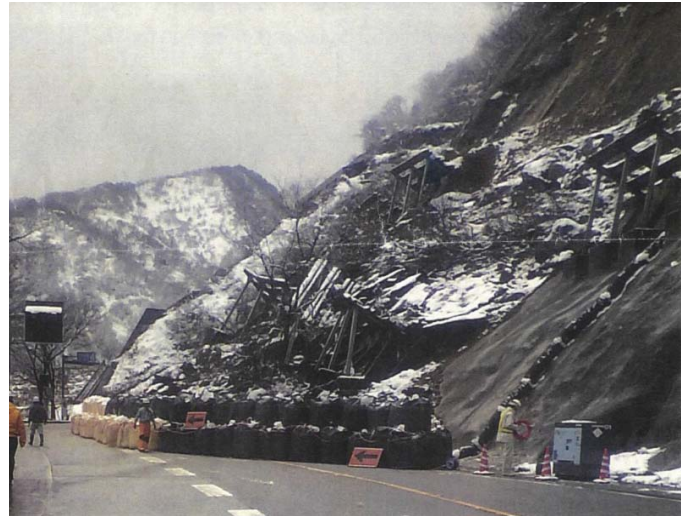
写真1 平成26年4月東二口道路法面崩壊
