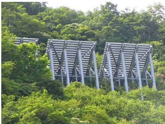
図10 設計積雪深12mに対応した雪崩予防柵
