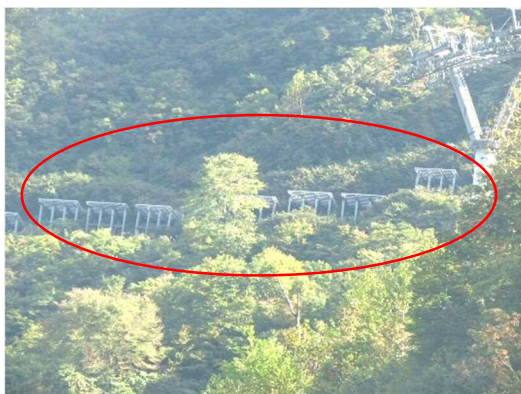
図11 設計積雪深10mに対応した雪崩予防柵
