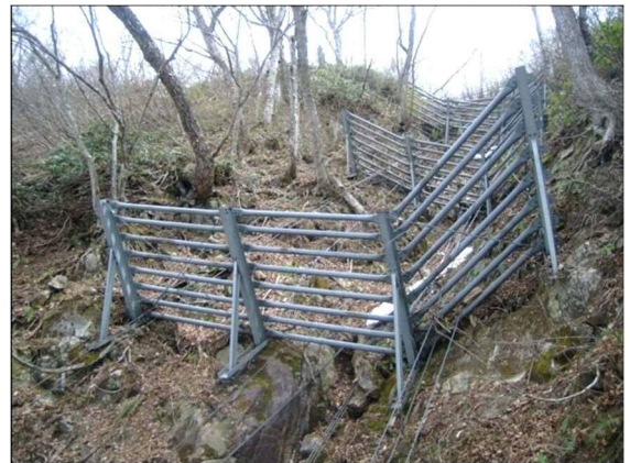
図17 凹凸斜面に設置された吊柵
