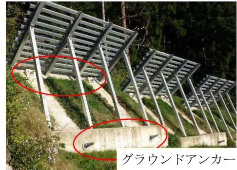
図12 アンカー基礎タイプの雪崩予防柵
