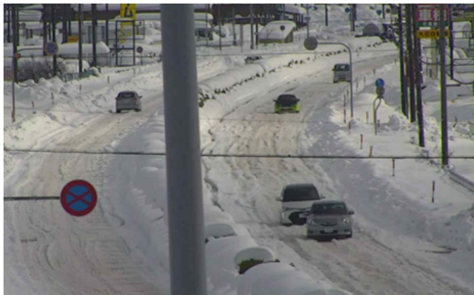
写真-1 国道8号の走行面が凸凹状況 (富山県射水市稲積)
