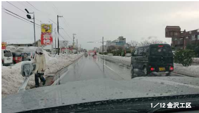
写真-3 拡幅除雪適正実施により生じる歩道堆雪
