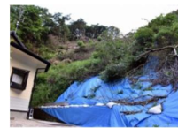
豪雨の度に土砂崩れが多発
