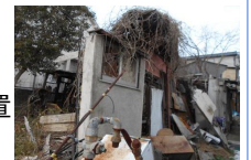
瓦礫の放置(火災跡)
