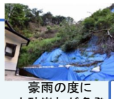
豪雨の度に 土砂崩れが多発
