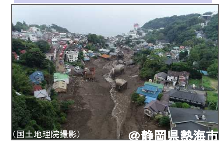
R3年7月豪雨による土砂災害
