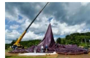
設置中の様子
