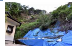
豪雨の度に土砂崩れが多発
