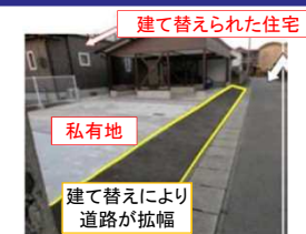
狭隘道路の解消となった例
