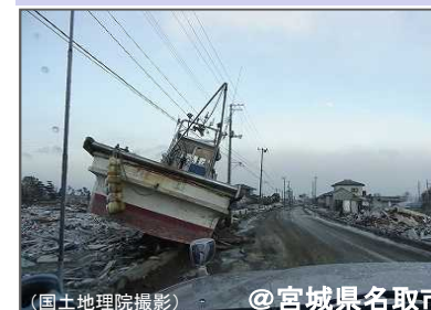
東日本大震災時の津波被害
