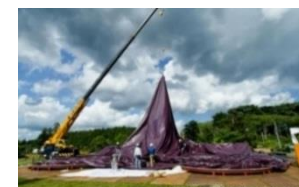
設置中の様子
