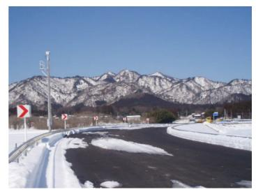
朝日まほろばIC手前の状況です。CCTVカメラや 自発光式矢印板が設置されています。今後、セン ターライン、センターポール及びブロック等を施工 します。(2月23日撮影)
