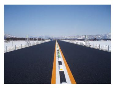
朝日三面IC~朝日まほろばIC区間で最後に着手した 箇所です。舗装、センターライン、センターポール及び ブロックが完了しています。今後、ガードレールや外側 の区間線を引いて完成です。(2月23日撮影)
