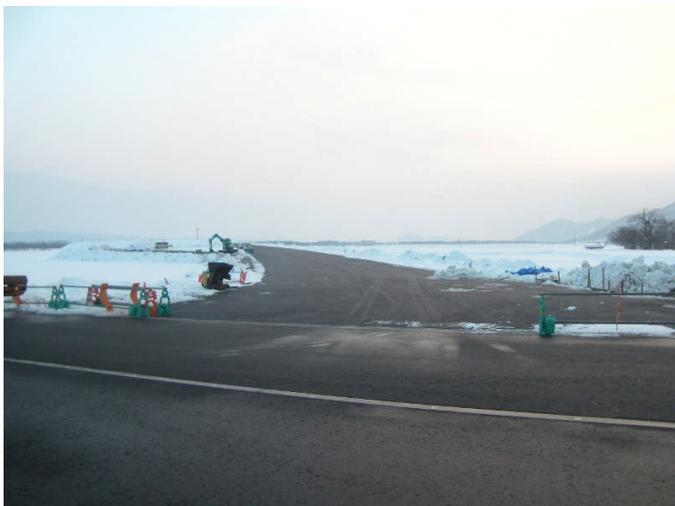
朝日まほろばICです。表層(3層目の舗装)が完了しました。現在、ガードレールの基礎を施工中です。この後、防護柵工事、区画線工事、照明灯等附属施設工事を進めます。(1月24日撮影)
