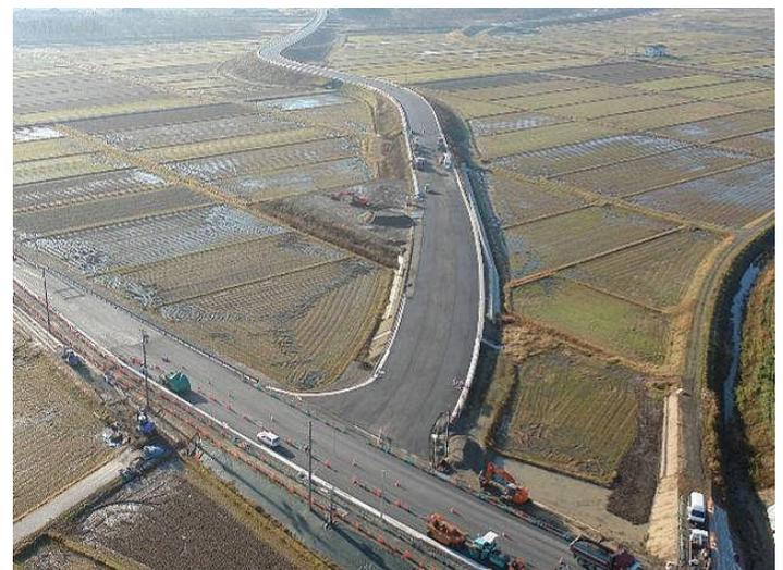
朝日まほろばICです。ここで県道小揚・猿沢線と接続します。基層(2層目の舗装)が完了し、ガードレールの基礎・支柱を施工中です。今後、表層(3層目の舗装)を施工します。
