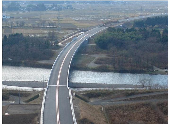
三面川に架かる橋梁です。センターの区画線が完了しています。今後、簡易中央分離帯の設置を進めます。
