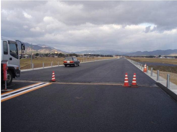
朝日三面ICから朝日まほろばIC方面を見た写真です。基層(2層目の舗装)が完了し、ガードレールの支柱を施工中です。今後、表層(3層目の舗装)を施工します。
