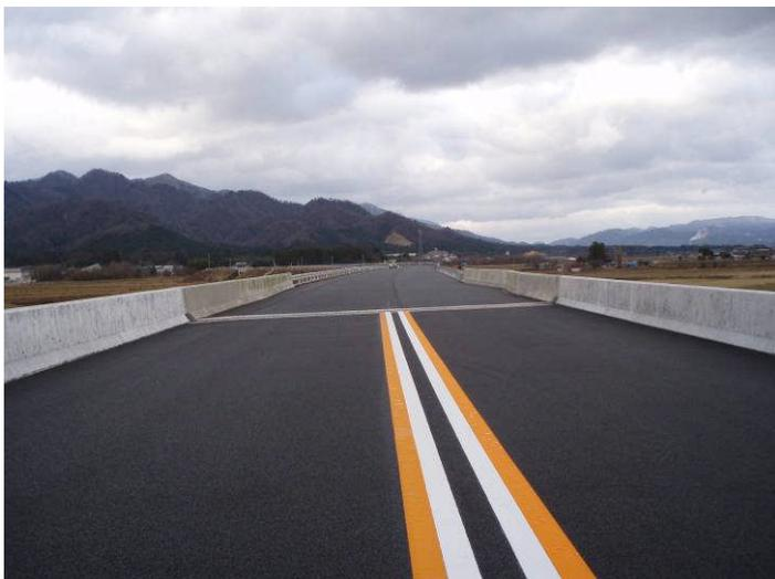
高根川に架かる橋梁から朝日まほろばIC方面を見た写真です。センターの区画線と簡易中央分離帯の設置とともに、道路附属物の設置を進めます。
