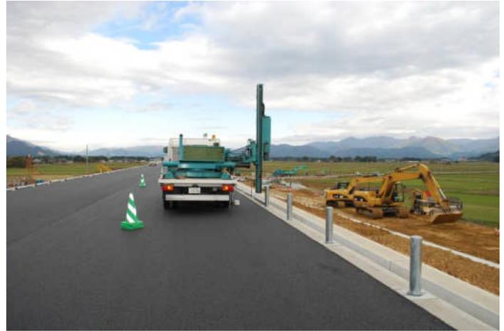
天神岡地先の本線上です。2層目のアスファルト舗装が完了し、ガードレール支柱を設置している状況です。この後、表層(3層目のアスファルト舗装)を施工し、区画線やガードレールのレール部分を設置します。
