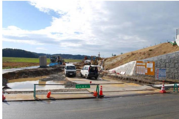
朝日三面ICのオンランプ部です。ランプ部の盛土と排水路を施工しています。
