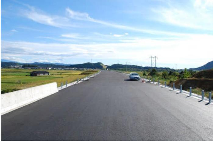
小谷川付近から村上市街方面を望んでいます。2層目のアスファルト舗装が完了し、ガードレール支柱打設も完了しています。遠くには、仲間丘陵切り土部が見えます。
