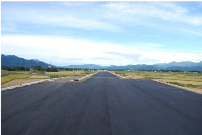
朝日三面ICの本線部です。アスファルト安定処理が完了し、ガードレール支柱の沈下防止基礎と防草コンクリート及び附属施設を施工中です。
