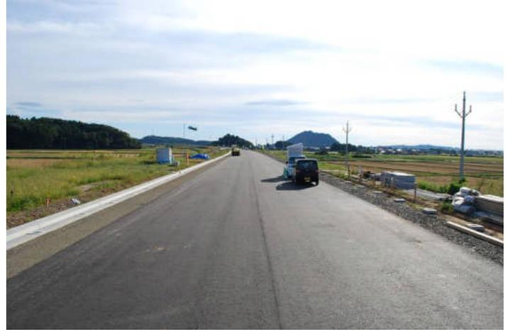
天神岡地先の本線上です。アスファルト安定処理が完了した状況です。並行してガードレール支柱の沈下防止基礎と防草コンクリートを施工中です。
