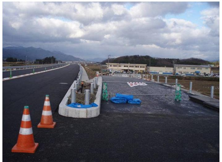
村上山辺里IC付近の施工状況です。本線は道路本体工事が完了し、標識等の附属施設を施工中です。オンランプ部の舗装が完了し、オフランプ部の舗装を施工中です。
