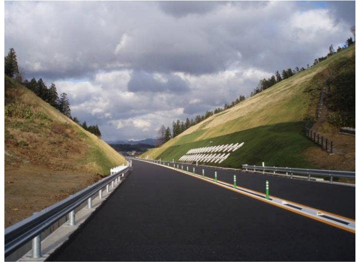
仲間町地区大切り土部の施工状況です。道路本体工事は完了し、残すは標識、非常電話等の附属施設のみです。現在、施工中です。
