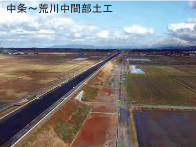
中条～荒川中間部土工
