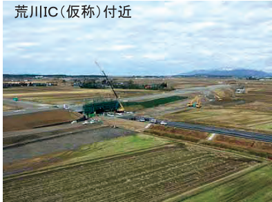
荒川IC(仮称)付近
