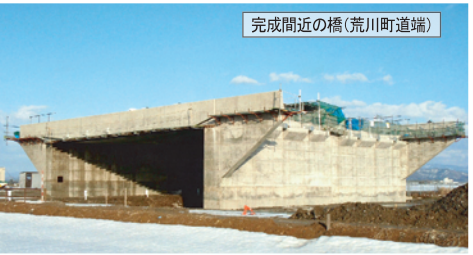
完成間近の橋(荒川町端)
