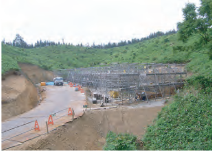
No.82付近函渠工(6月14日現在)
