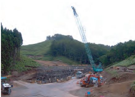
No.88付近函渠工(6月14日現在)
