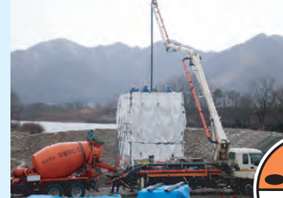
コンクリート打設時の状況
