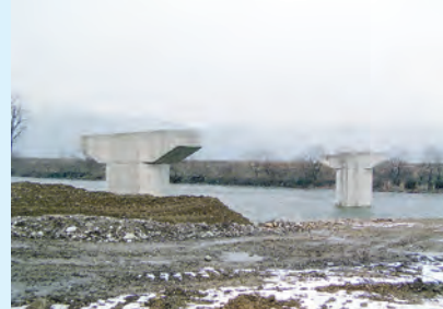
現場状況(3月22日時点)
