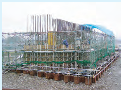
橋台(A2)状況(3月22日時点)
