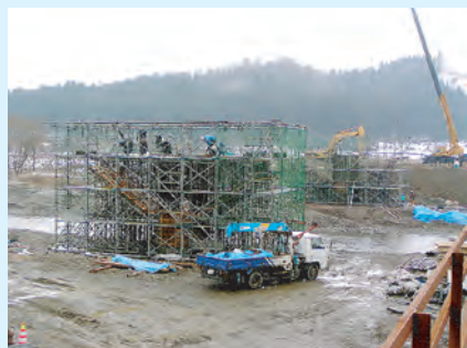
橋脚(P1)状況(3月22日時点)
