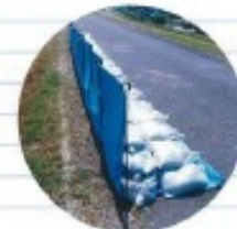
川側から見た完成状態
