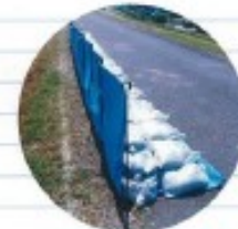
川側から見た完成状態
