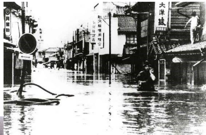
浸水状況(坂町駅前)
